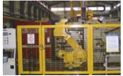
산업용 로봇 방책 설치
