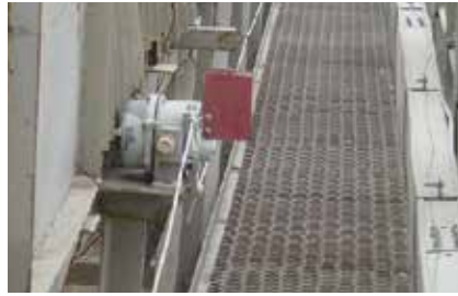
컨베이어 비상정지장치 (폴코드 스위치) 설치
