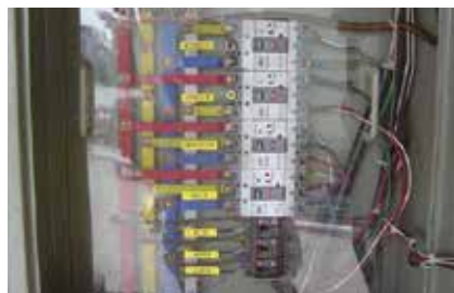
전기충전부 절연덮개 설치
