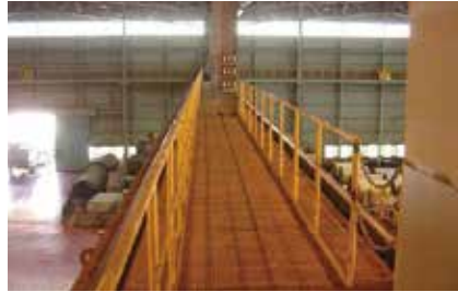
점검 보수통로 안전난간 설치
