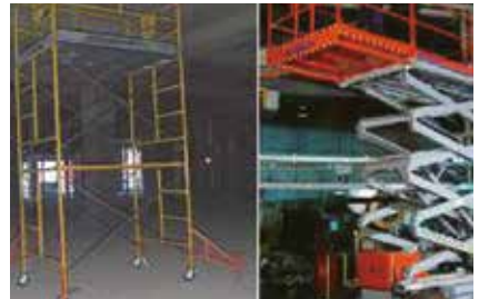
떨어짐 위험지역 작업발판 설치 또는 고소작업대 사용
