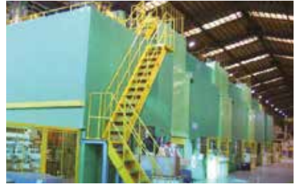
대형설비 상부 점검통로 안전난간 설치
