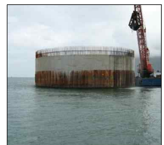
교량 우물통 공사
